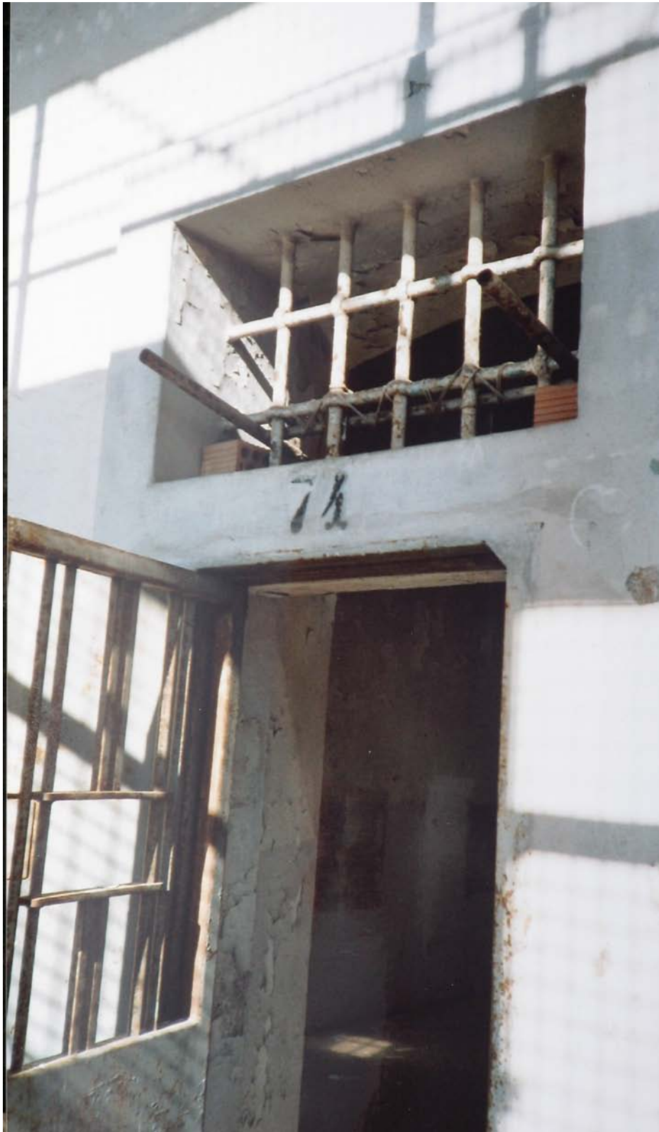
Ingresso alla camerata n. 74 Primo piano della Casa di Pena di Piazza Castello (Padova).
