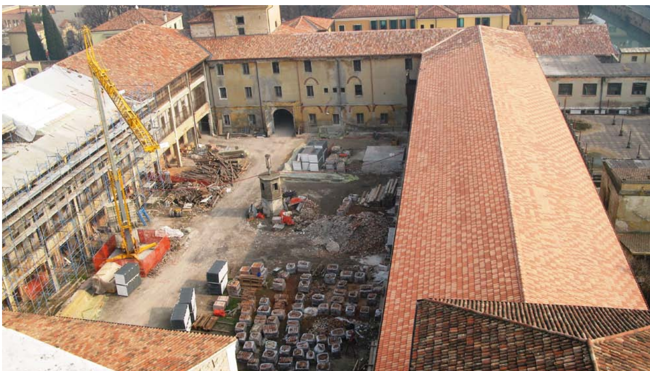
Ex carcere di Piazza Castello a Padova in restauro (foto aprile 2009).
